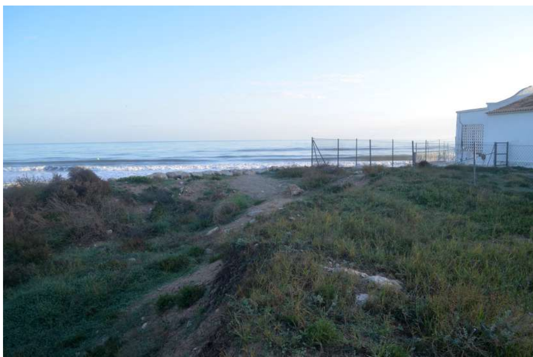
A.M.G. 002. Fotografia general est. Casamata les Deveses IV.
